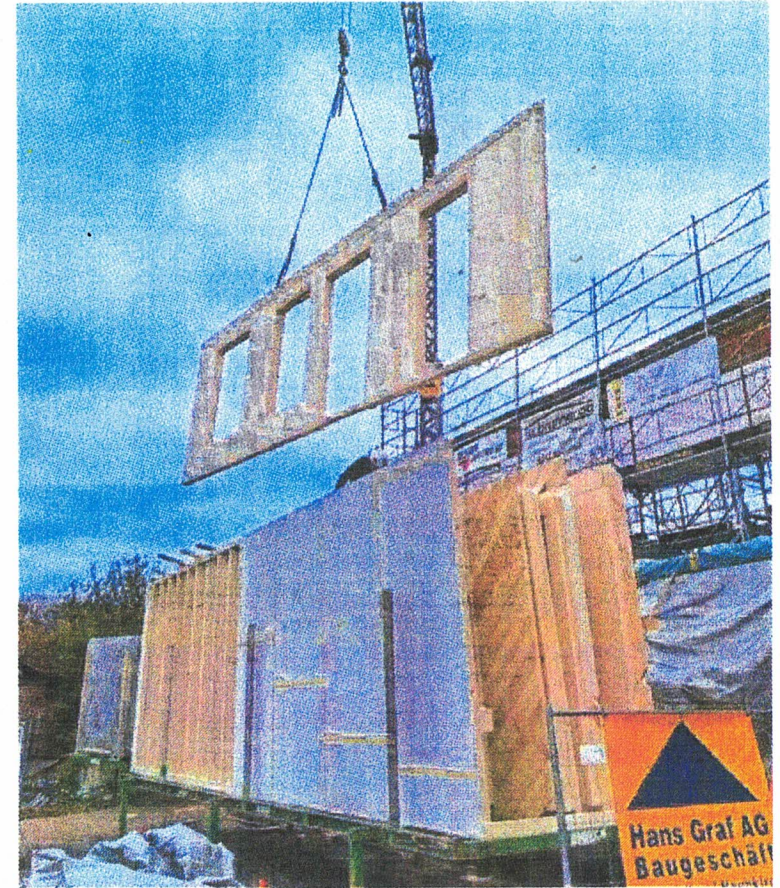
Gestern wurde der Holzteil des Randenzentrums fertiggestellt.
